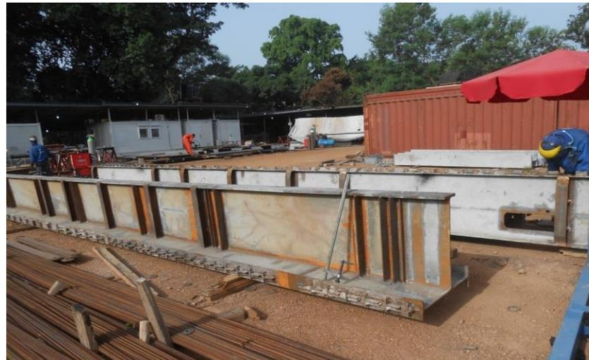
Baustellenfertigung der Ankerträger für die Korrosionsschutzplattformen
