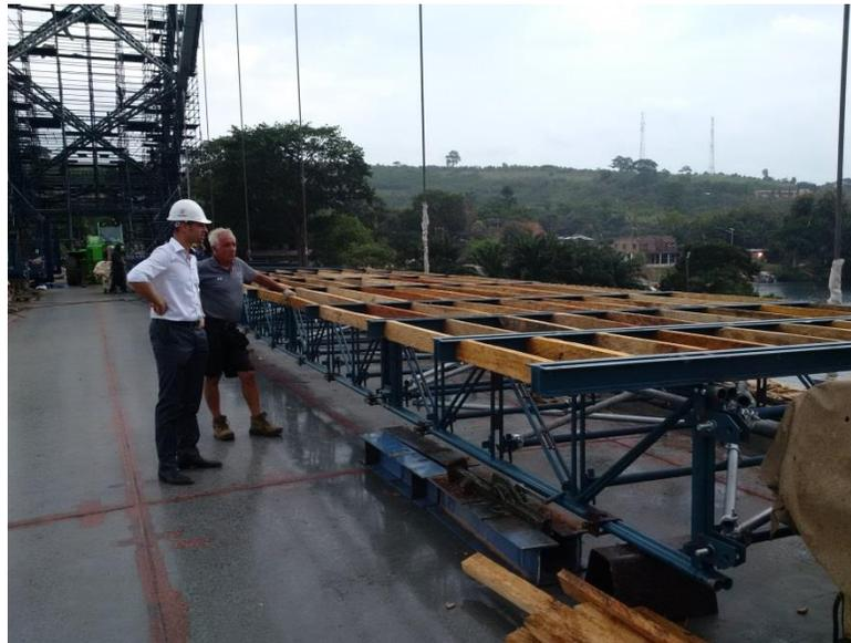
Zusammenbau der Korrosionsschutzplattformen am Brückendeck
