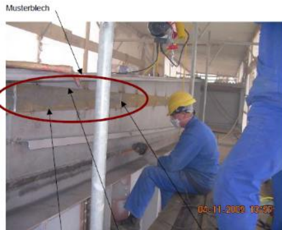
Schweißen der Längsnähte mit a 6mm
