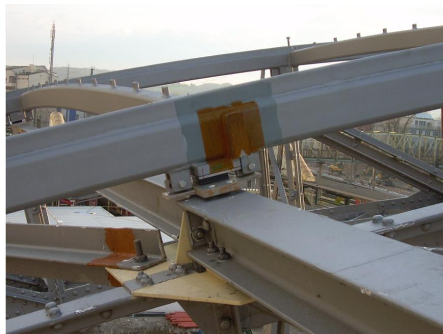
Gelenkige Lagerung der Dachkonstruktion auf den Tonnenbindern
