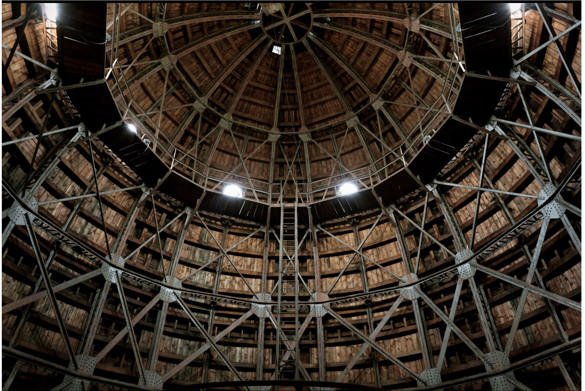
Hofburg, Dachkonstruktion der Michaelerkuppel
