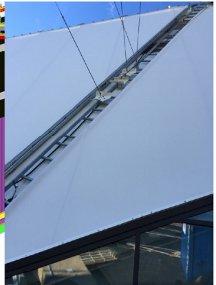
STAKO Fassade Ost: UK Konsolen Aufhängung Leitungen E Bus
