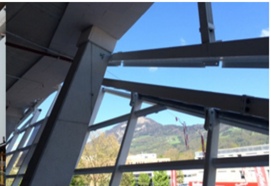
STAKO Fassade Ost: UK Konsolen Aufhängung Leitungen E Bus
