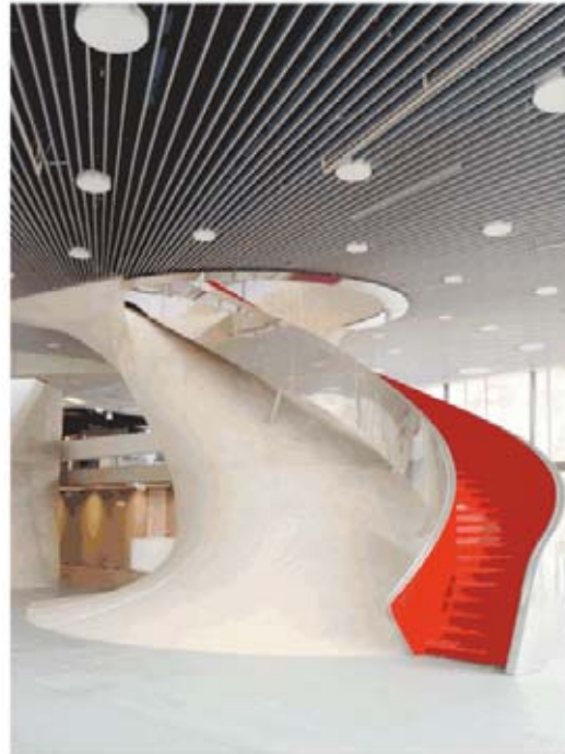
Abb. 2: Twist mit aufgesetzter Stahlstiege
