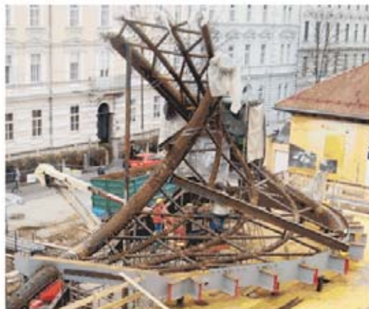
Abb.5: Zusammenbau Stahlfachwerk
