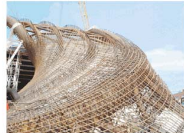
Abb. 7: Bewehrung der Betonschale auf Stahlfachwerk verteggt
