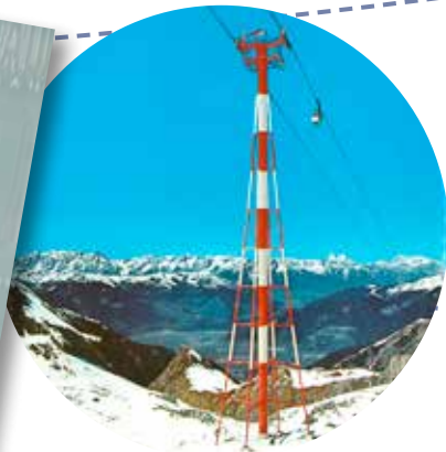
102 m hohe Seilbahnstütze der Gletscherbahn Kaprun. Ausgezeichnet mit dem europäischen Stahlbaupreis 1974.
