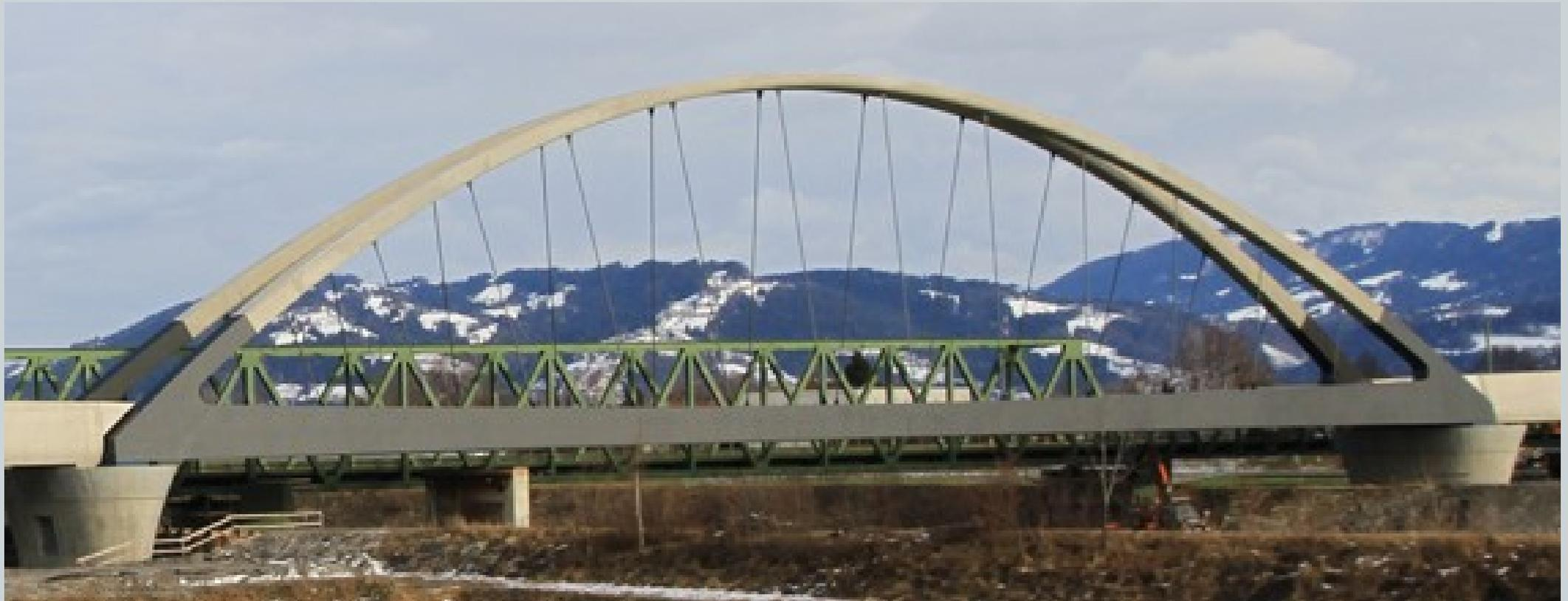
BX03 Rheinbrücke, 24 Hänger,  $L_{\max} \approx 19$  m, Vollquerschnitt,  $\varnothing 100$  mm, S355NL
