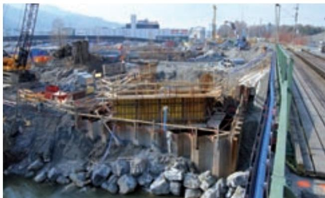
*Baulos 3: Errichtung eines Widerlagers der Brücke über den Rheintaler Binnenkanal*
