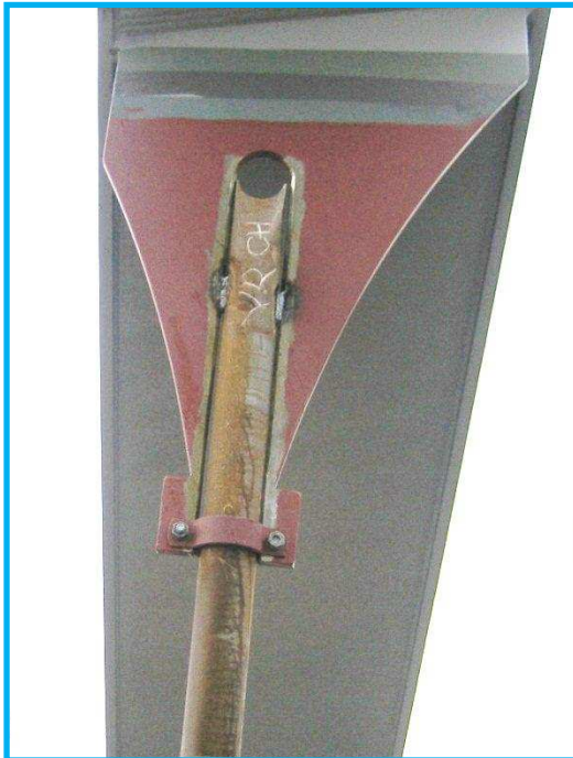
Oberer und unterer Hängeranschluss
