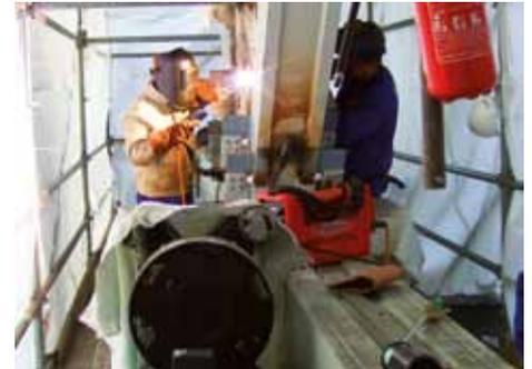
*Verschweißen der Fachwerke mit Erläuterung: Im Bild können die großen Blechdicken der Fachwerke erkannt werden. Eine durchschnittlich 400 mm lange und 80 mm starke Naht erforderte ungefähr 20 h reine Schweißzeit. Es wurden auf der Baustelle bis zu 16 Schweißer gleichzeitig beschäftigt.*
