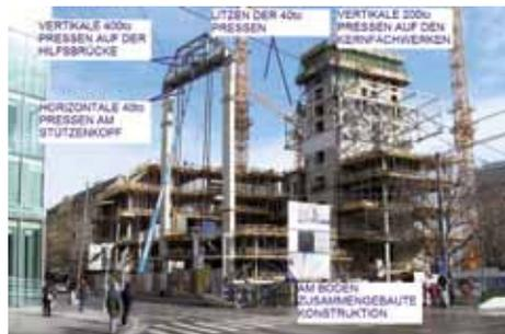
*Ausgangssituation 25. 2. 2009 mit Erläuterung: Über den zwei Hauptstützen ist eine Hilfsbrücke angeordnet. Auf der Hilfsbrücke wurden vier 400-t-Pressen situiert. Auf den bereits montierten Kernfachwerken wurden vier 200-t-Pressen angebracht. Die Litzen der zwei horizontalen 40-t-Pressen wurden am Kern rückgehängt.*
