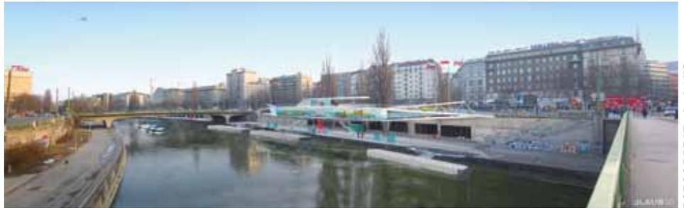
Schiffstation Wien City: Die volle Länge des 140 Meter langen Bauwerks ruht auf nur drei Stützen.
