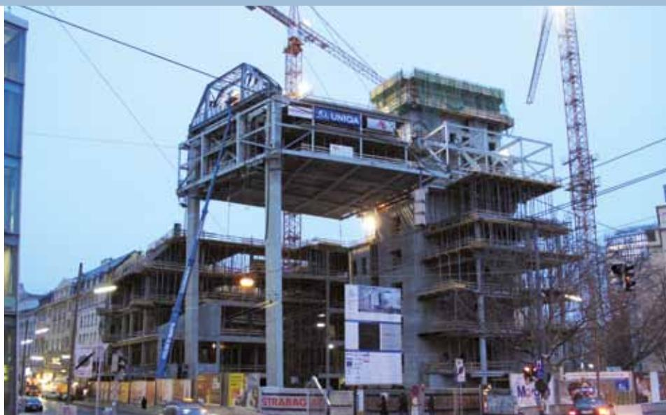
*Situation 26. 2. 2009, 18.30 Uhr mit Erläuterung: Die Konstruktion befindet sich ca. 30 cm unterhalb der Solllage. Nun wurde begonnen, die planmäßig während des Hubes ca. 5 cm nach außen gedriftete und 1.600 t schwere Konstruktion zum Kern zurückzuziehen und in ihre Solllage zu ziehen.*
