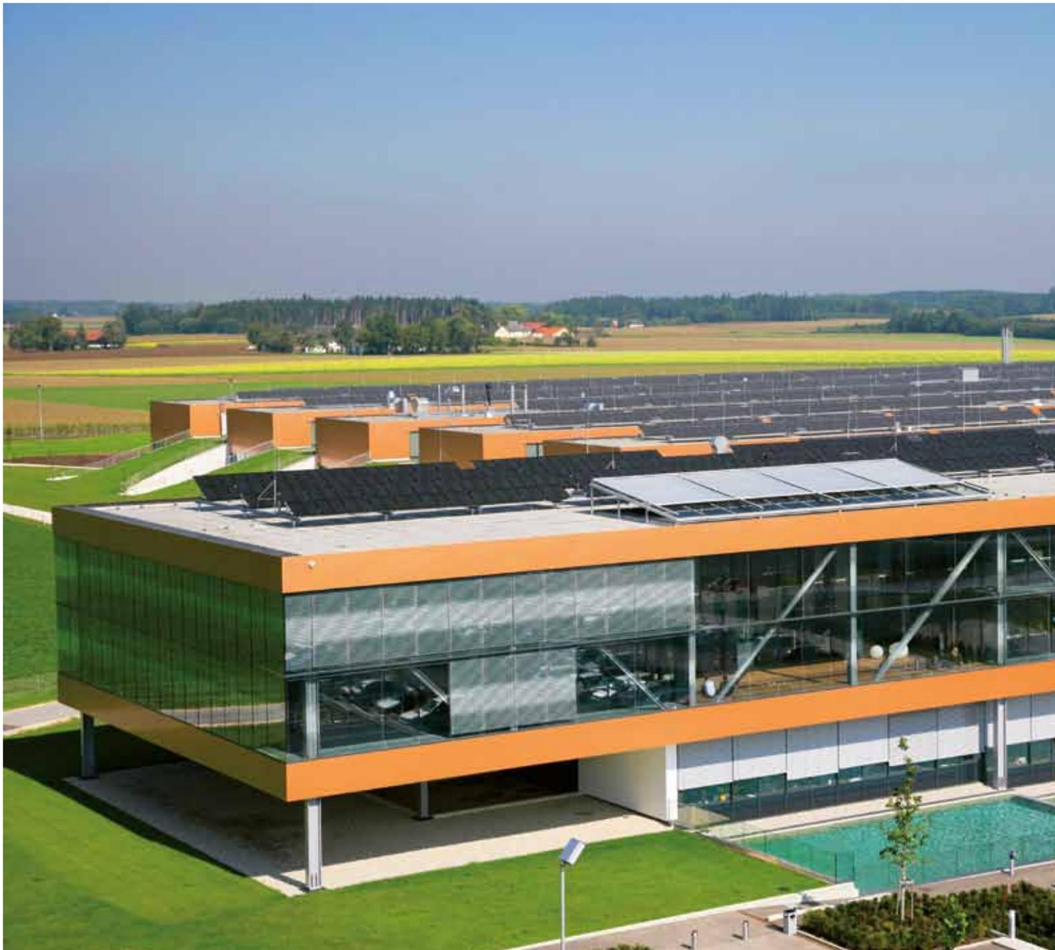
Österreichs größte Flachdach-Photovoltaikanlage auf Stahlunterkonstruktion leistet 608 kWp, bei einer Modulfläche von 3.500 m<sup>2</sup>. Die Jahresstromproduktion beträgt 550 MWh.
