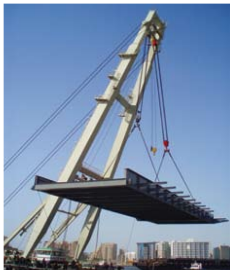
Übergangsrampe am 400-t-Schwimmkran hängend
