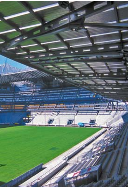
ein harmonisches Bild. Die Aufstockung ist für den Stadion-
