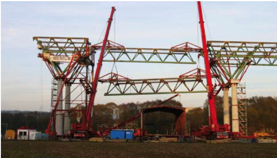
Montage Feldsegment mit Mobilkranen
