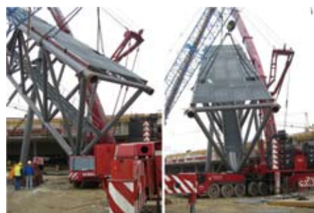
Abb. 2: Situation nach dem Absturz des Trägers
