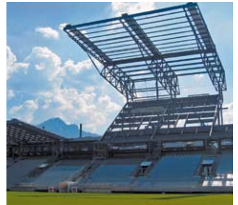
An der Westseite ist die Stahlkonstruktion von zwei Verbandsfeldern fertig gestellt. Links sieht man noch den Zustand vor dem Ausbau.
