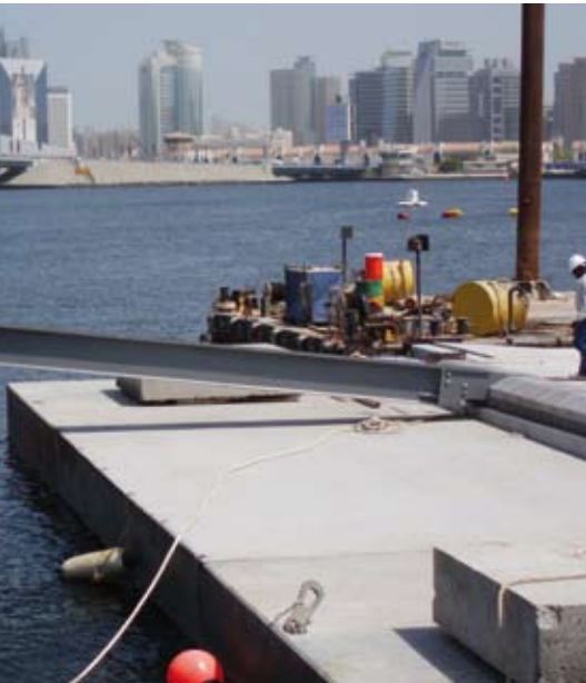
Das erste der 28 Transitionselemente ist eingebaut
