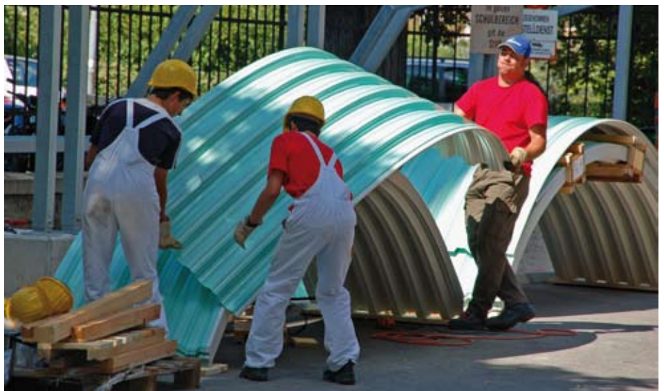
Gemeinsam mit Mitarbeitern der Firma Zeman Stahlbau wurden die Überdachungen wie abschließend die Fahrradständer in nur acht Arbeitstagen montiert.
