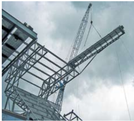
Einheben des 24 m langen Bestandsdaches gemeinsam mit der bestehenden Dacheindeckung durch einen beweglichen Raupenkran. Das Dach wird von 16 m Höhe auf über 43 m hochgehoben.
