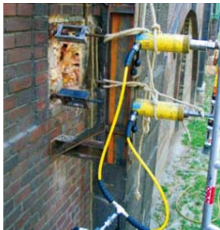
Prüfung der Anker (bei demontiertem Mast)
