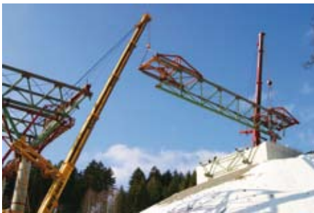
Einhub Feldsegment im Randfeld Achse 80-90
