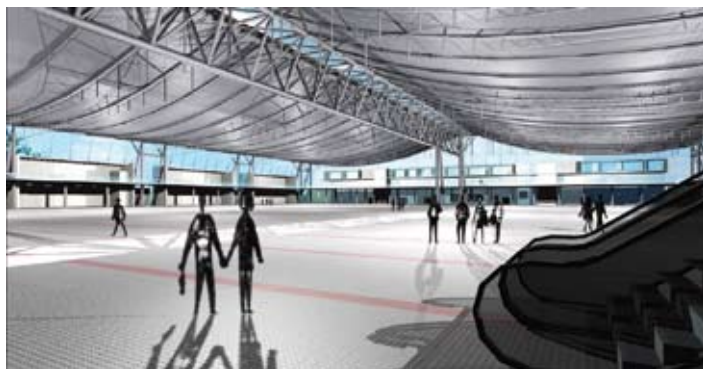
Abb. 1: Hochhalle der Neuen Messe Stuttgart mit Dreigurtfachwerk. Quelle: www.landesmesse.de . Zugriff: Jänner 2007
