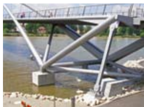
Abb. 4: Ostseite (Weil/Rhein): längerverschiebliche Dreheinspannung
