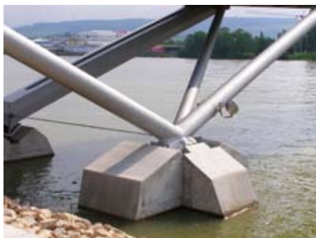
Abb. 5: Westseite (Huningue): unverschiebliche Dreheinspannung
