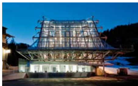
Architektonischer Stahlbau – Ein Blickfang in St. Anton
