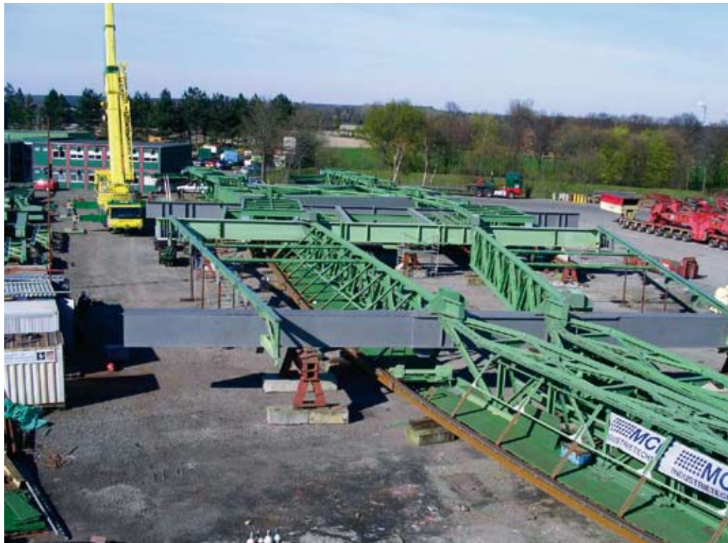
Vorzusammenbau in Moers
