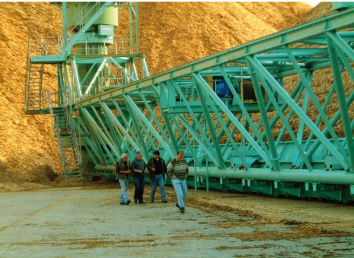
Reclaimerbrücke mit Centre Column
