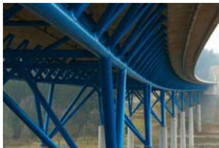
Stahlkonstruktion inklusive Deckansicht
