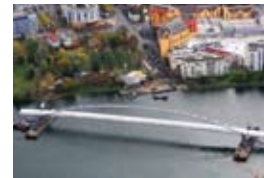
Abb. 6: Einschwimmen und abschließendes Eindrehen mit Seilwinden
