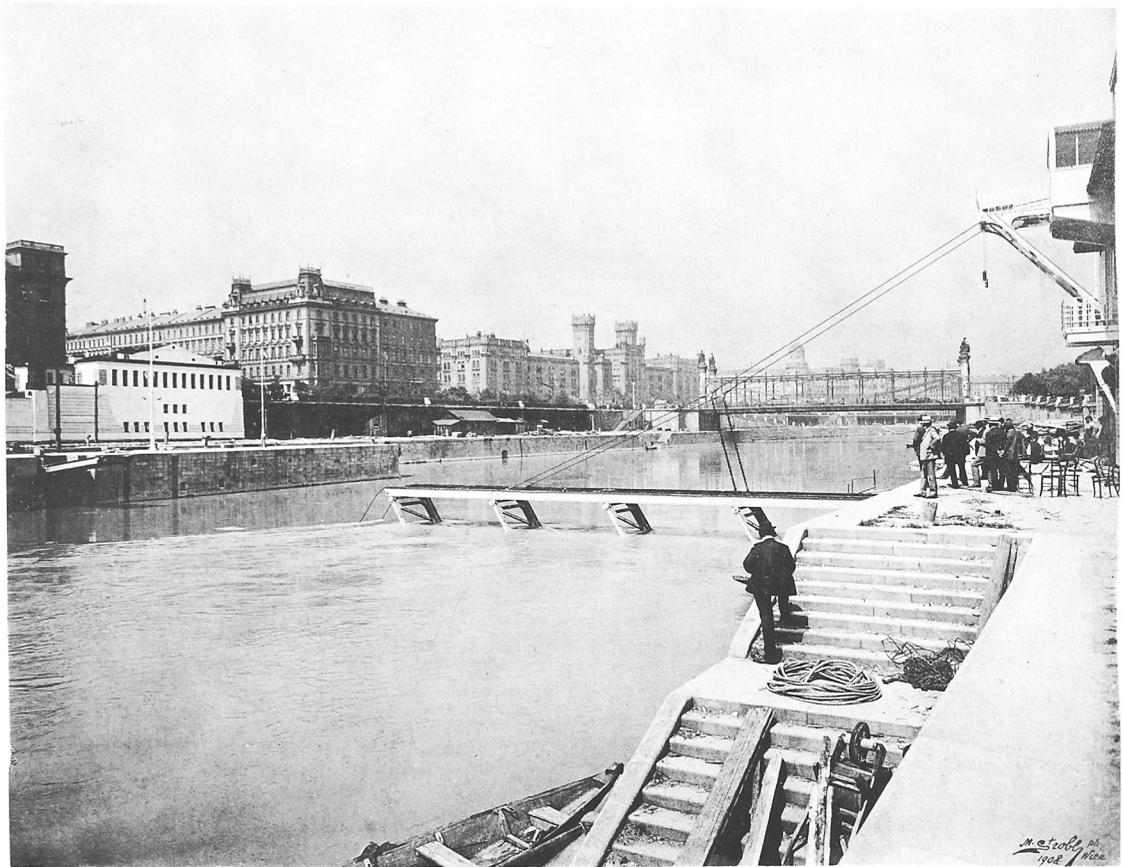
Fig. 3. Das Einstellen der Schützen mit dem Schützenkran.
