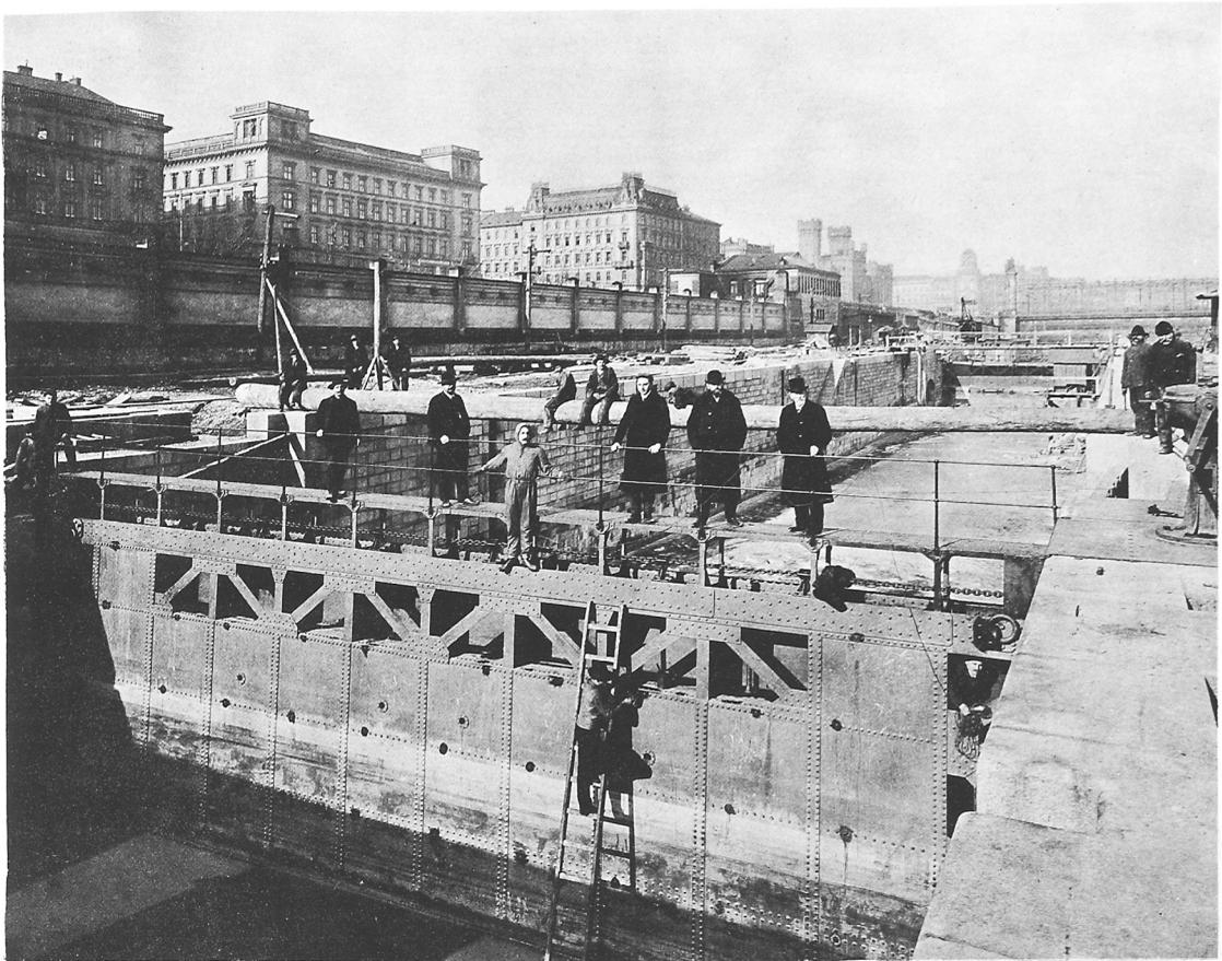
Fig. 4. Das fixe Wehrkrangerüste in Montage.
