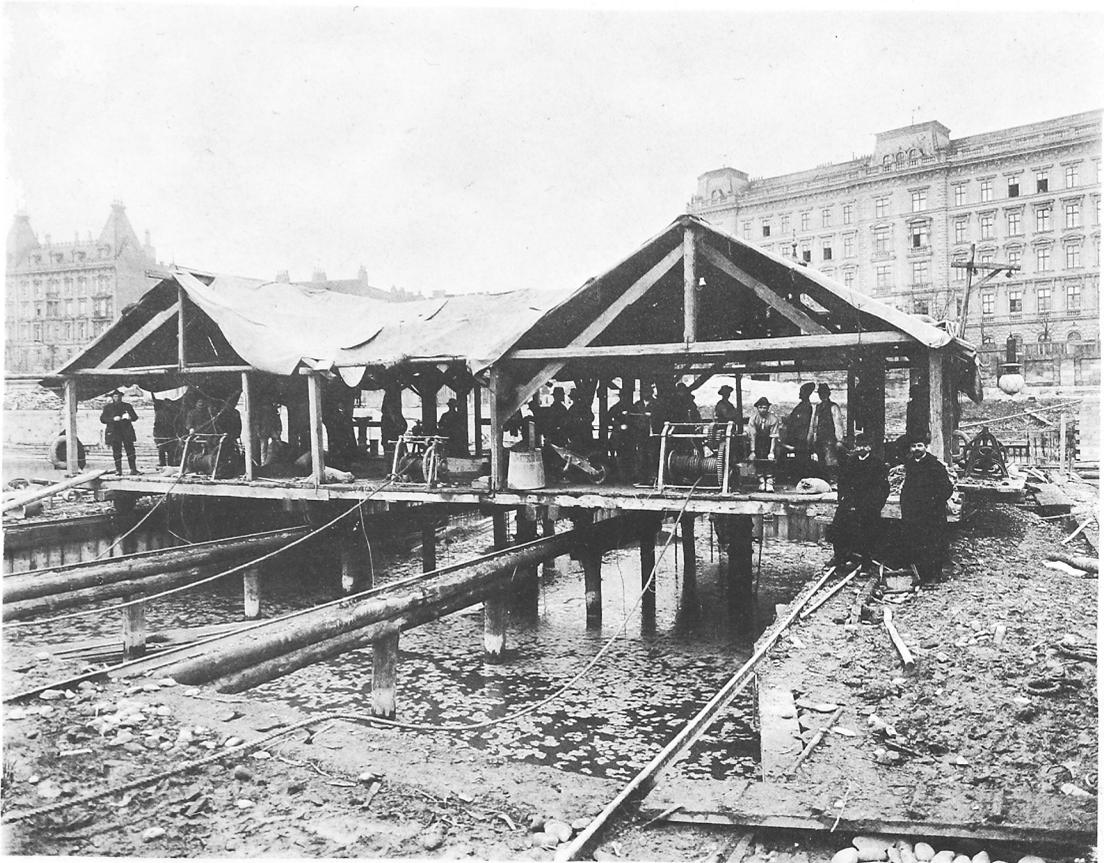
Fig. 3. Die Naßbetonierung der linken Wehrbaugrube.
