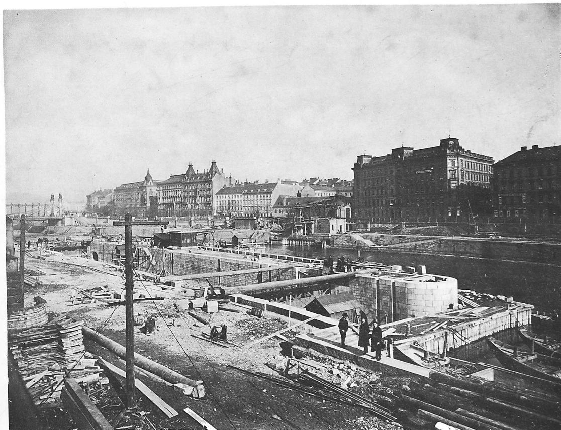
Fig. 1. Die Naßbetonierung der rechten Wehrbaugrube.
