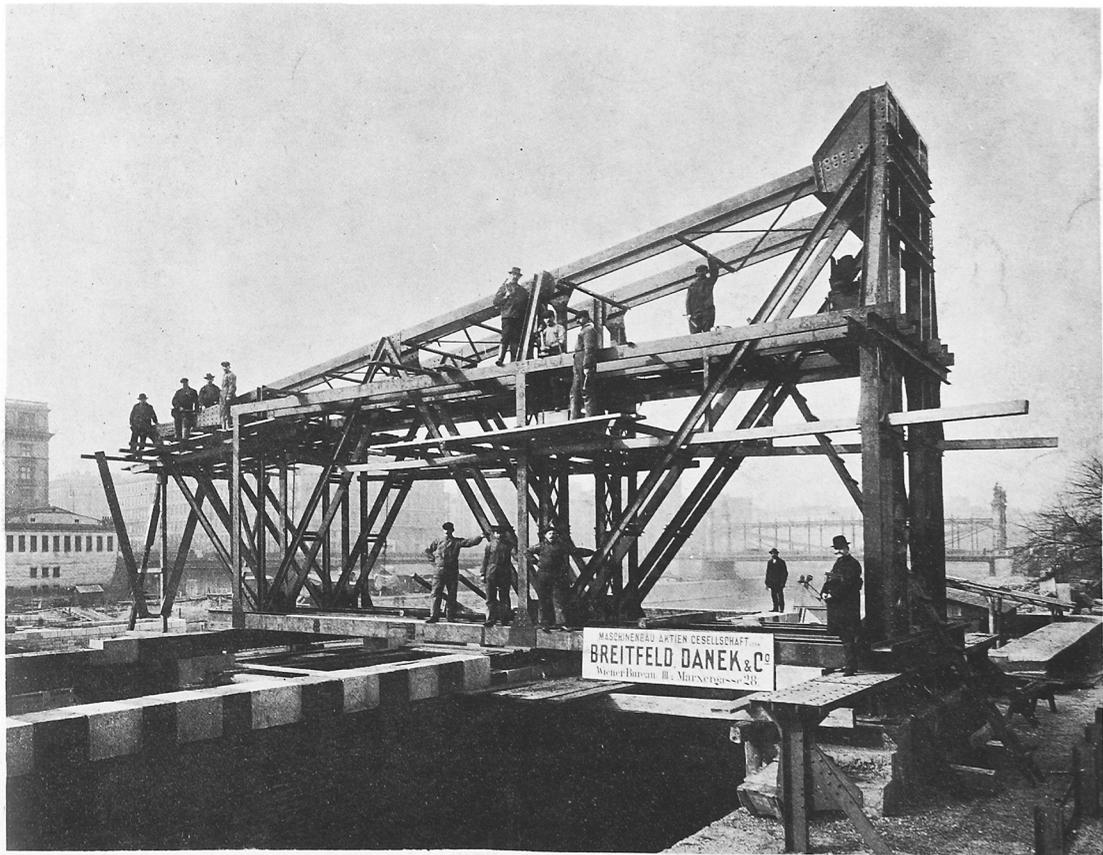
Fig 1. Anheben des linken Wehrteiles.
