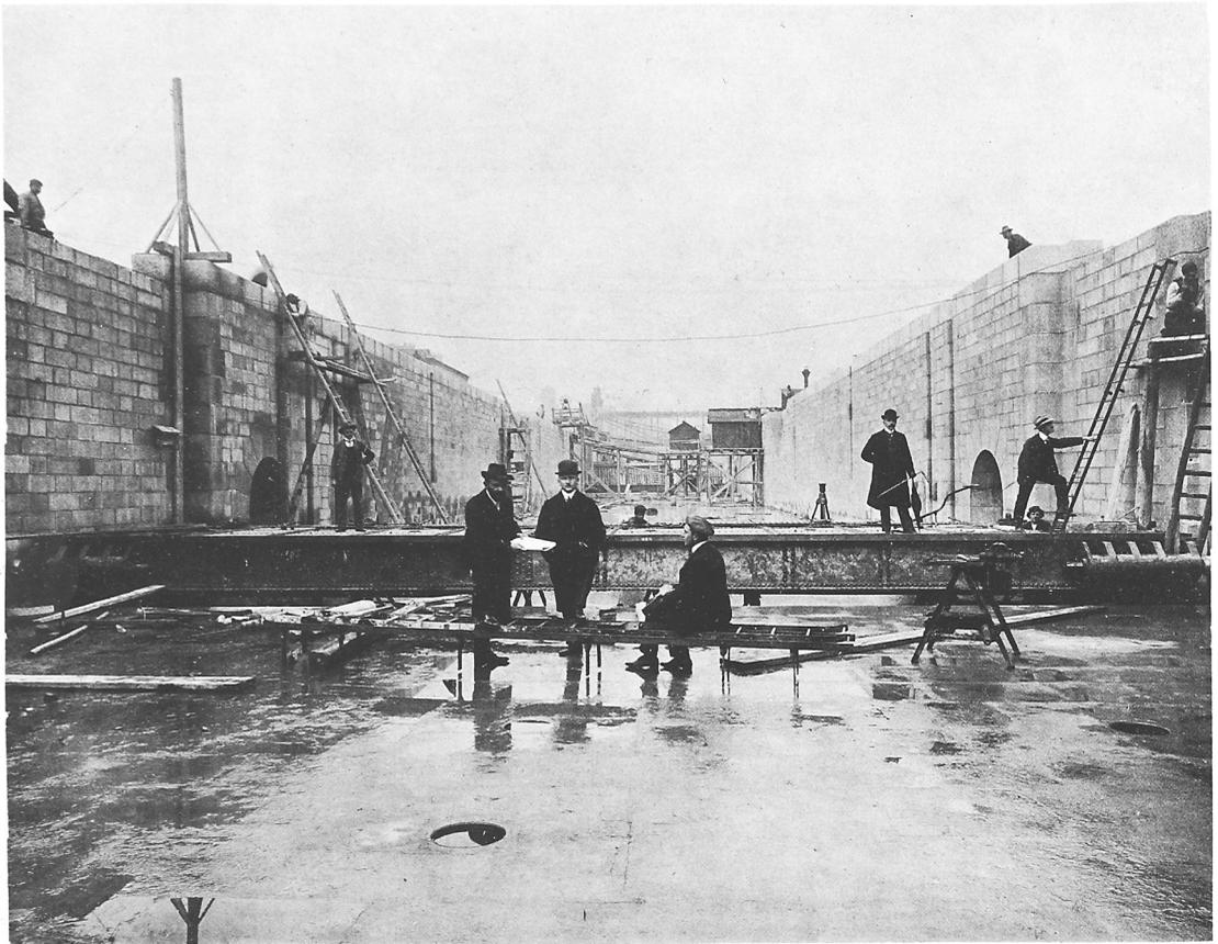
Fig. 3. Die montierten Blockständer in der linken Wehrbaugrube.
