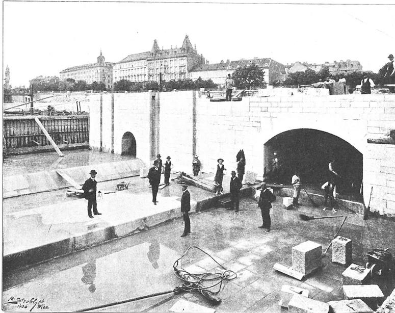
Umlaufkanal des Schleusenoberhauptes mit Schleusenpfeiler.
