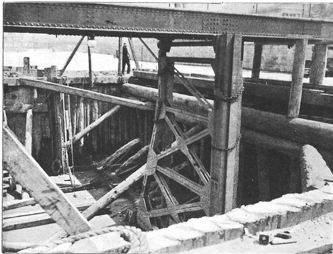
Textfigur 16. Anbohrung der Schiffswand zur Füllung der Wehrbaugrube vor Abtragung dieser Wand.
