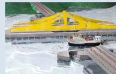
—Die neue zweigleisige Eisenbahn-Drehbrücke über den Prai River wird technisch einiges in den Schatten stellen. In nur 2 Minuten öffnet sich der 90 Meter lange und 1100 Tonnen schwere Drehteil auf seiner riesigen Antriebsachse. Sie wird genauso verlässlich sein wie die Vorgängerbrücke, die seit 1964 ununterbrochen im Dienst stand. Und die war auch von Waagner-Biro.
