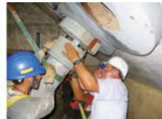
geschützt worden. Schlussendlich traf der Generalunternehmer die Entscheidung, den Korrosionsschutz komplett zu erneuern. Die Haupttragseile der Originallieferung konnten nicht verwendet werden, da sie teilweise deutliche Knicke aufwiesen. Die Hänger hingegen waren in sehr gutem Zustand. Diese wurden in Kisten gelagert und waren überdacht. Die Feuerverzinkung wurde belassen und die Hänger wurden ohne bedeutende Zusatzmaßnahmen eingebaut.
