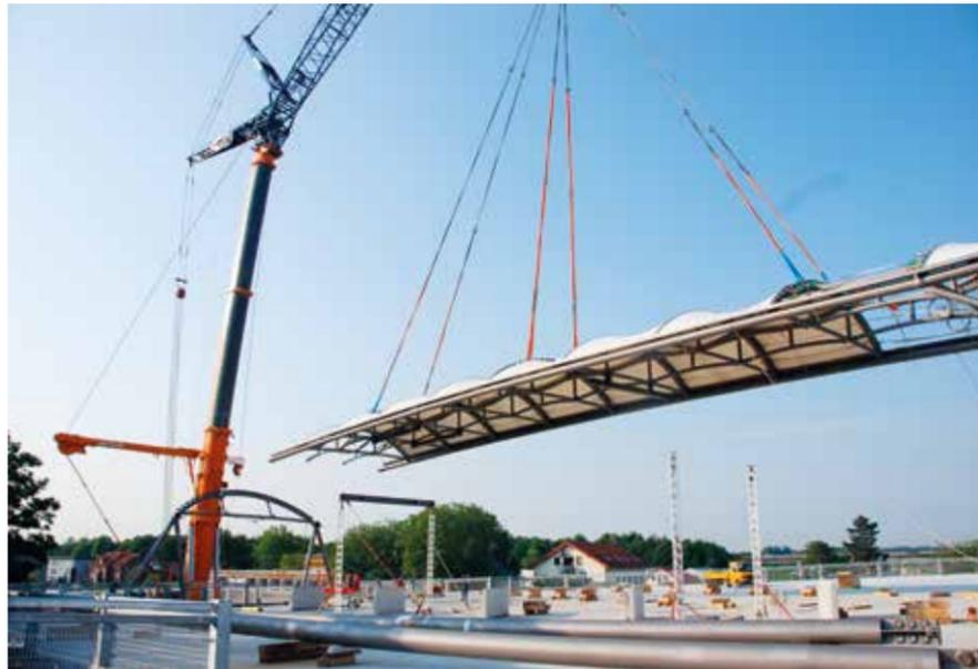
Das 50 m lange und 40 t schwere erste Teilstück des Membrandaches wurde auf die vorgesehene Höhe gehoben.
