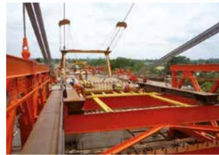
Verankerung der Kabelkrantragseile mit Seilspannvorrichtung
