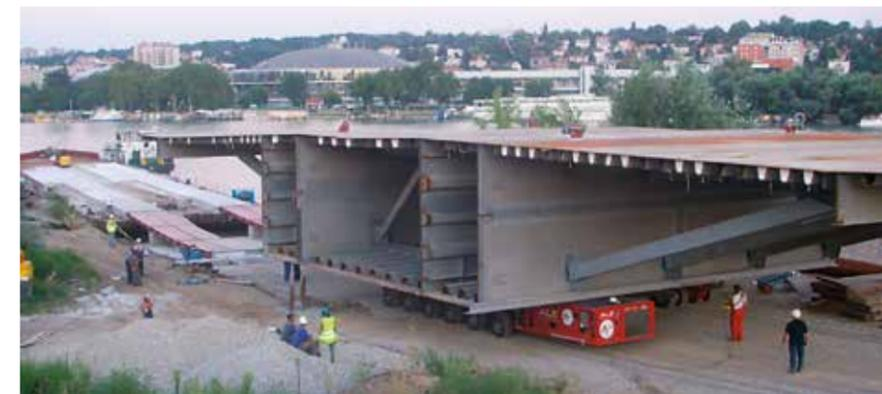
Transport eines 350 t schweren Stahlbausegments zum Ponton
