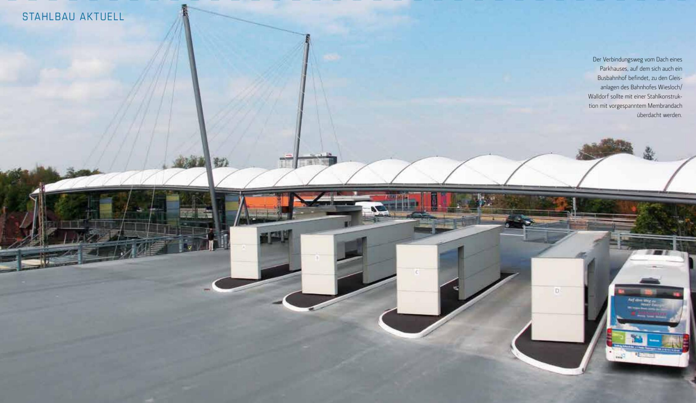
Der Verbindungsweg vom Dach eines Parkhauses, auf dem sich auch ein Busbahnhof befindet, zu den Gleisanlagen des Bahnhofes Wiesloch/Walldorf sollte mit einer Stahlkonstruktion mit vorgespanntem Membrandach überdacht werden.
