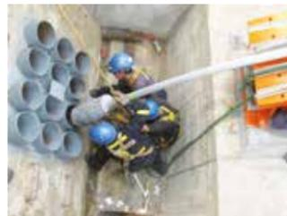
Einbringen und Befestigen eines Haupttragseils in der Ankerkammer
