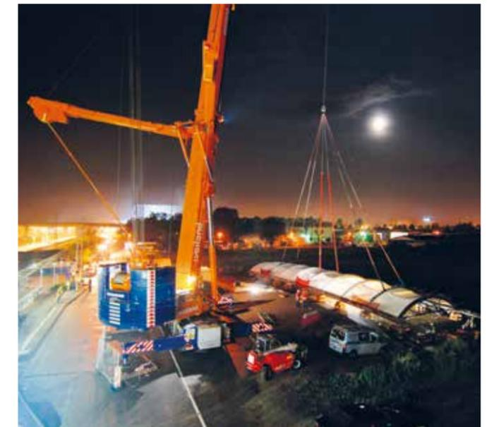
Jeweils eine Hälfte des Dachtragwerkes wurde am obersten Deck des Parkhauses bzw. in einer angrenzenden Grünfläche komplett zusammengebaut und mit einem 500-t-Kran auf die Endauflager bzw. Hilfskonstruktion eingehoben.
