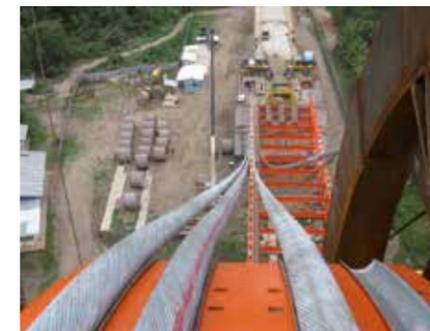
Rückhaltewiderlager mit Seilhaspel und Seilwinden sowie Zugwiderlager mit Seilwinden
