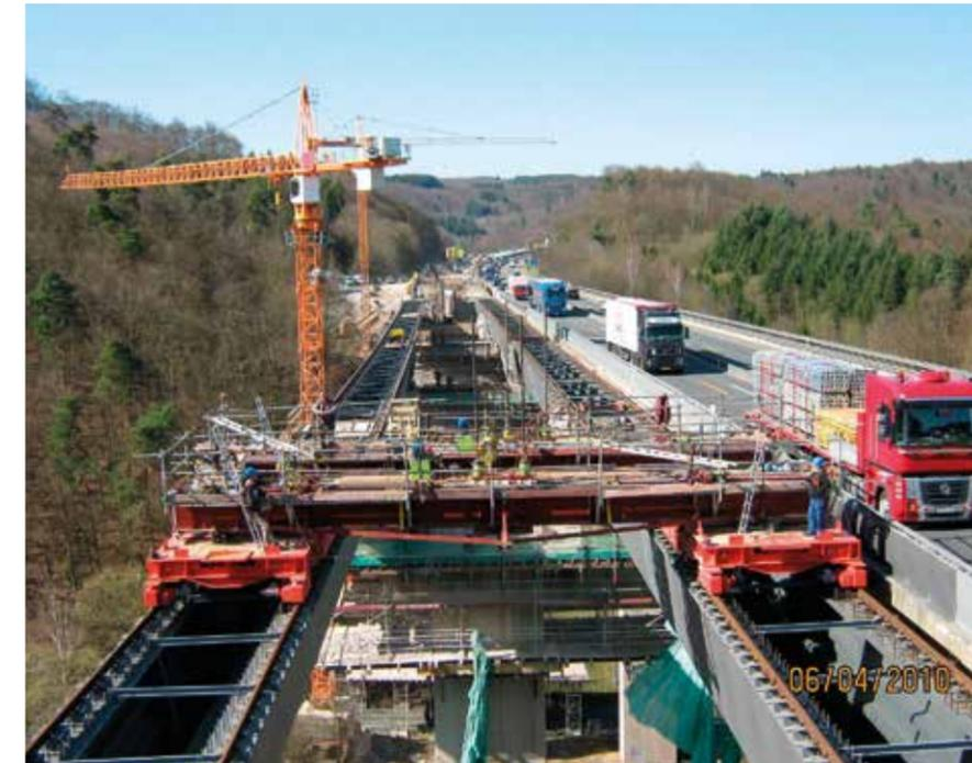
Ersatzneubau der Windelbachtalbrücke im Zuge der A45 (Hessen) in Stahlverbundbauweise
