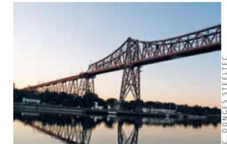
Beispielhafte Verstärkungsmaßnahmen für Fachwerke mit zusätzlichen Lamellen (hier an den Gerüstpfählern der Eisenbahnhochbrücke Rendsburg)
