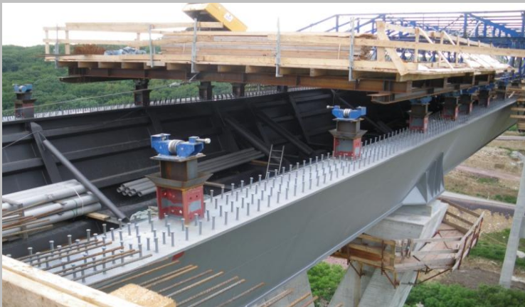
Nesselstalbrücke im Zuge der A4
