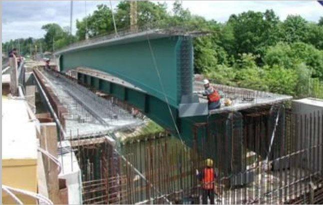
VFT-Träger für EÜ Teltowkanal beim Verlegen (Foto DB AG)
