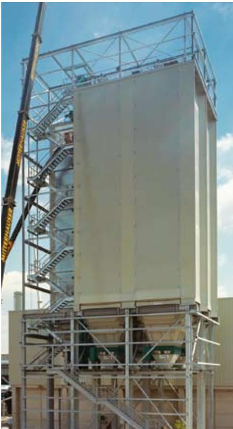
Mobilitätsgarantie: Erst die 13 Meter hohe Unterstützungskonstruktion von Peneder sorgt bei AVE in Wels dafür, dass 1.300 Tonnen Kunststoffpellets von den Silos auf LKW verladen werden können.
