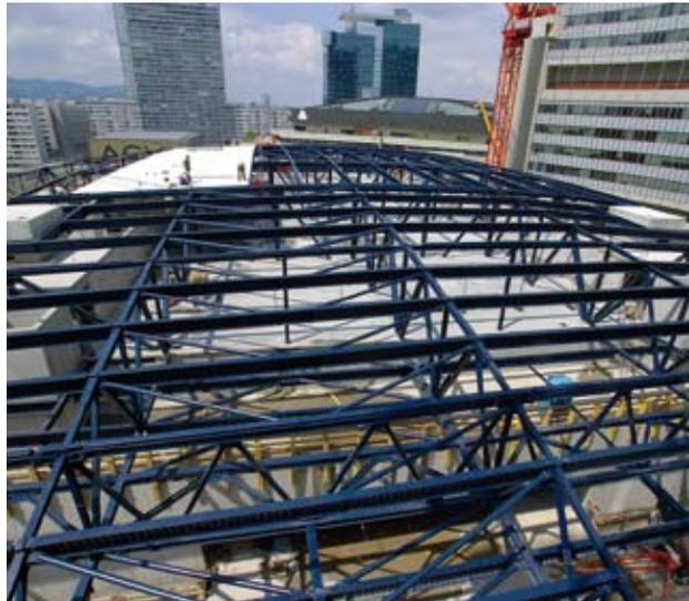
Dachdraufsicht mit teilweiser Trapezblechdeckung
