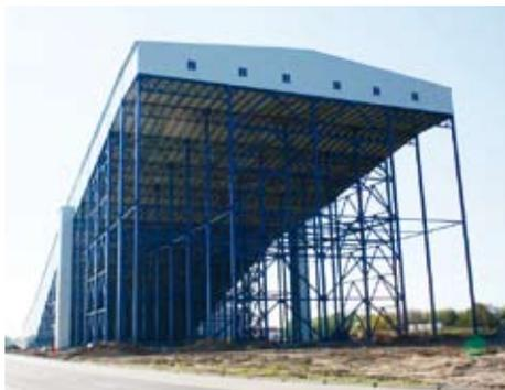
BRUCHA liefert und montiert zum Bau des Hochregallagers die dafür speziell geeigneten Fassaden- und Deckenpaneele sowie die da-
