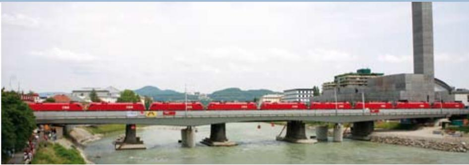
Bild 9: Probelastung Tragwerk Gleis 4
